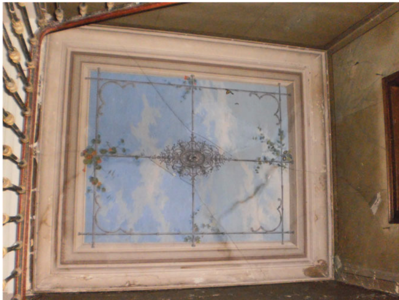
Photo du décor peint au plafond au dessus des escaliers réalisé dans la même esprit que celui du dégagement entre les deux salons : une verrière avec des faux éléments architecturaux de la structure, le ciel et les plantes. Une rosace en stuc moulurée est placée au centre de la « verrière ».
