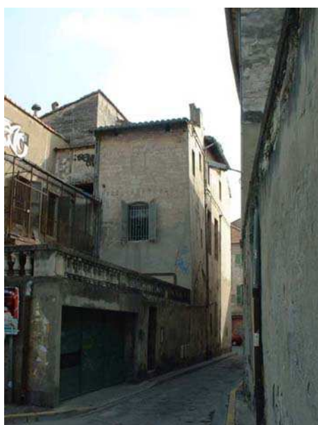
Photo de la façade arrière actuelle
